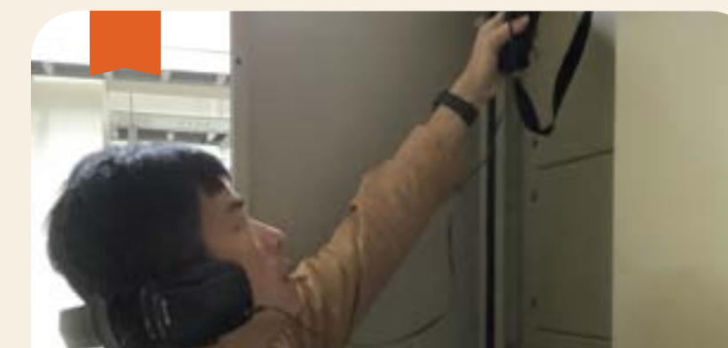
圖 4-22、企業損防顧問電氣設備安全檢測（超音波）
